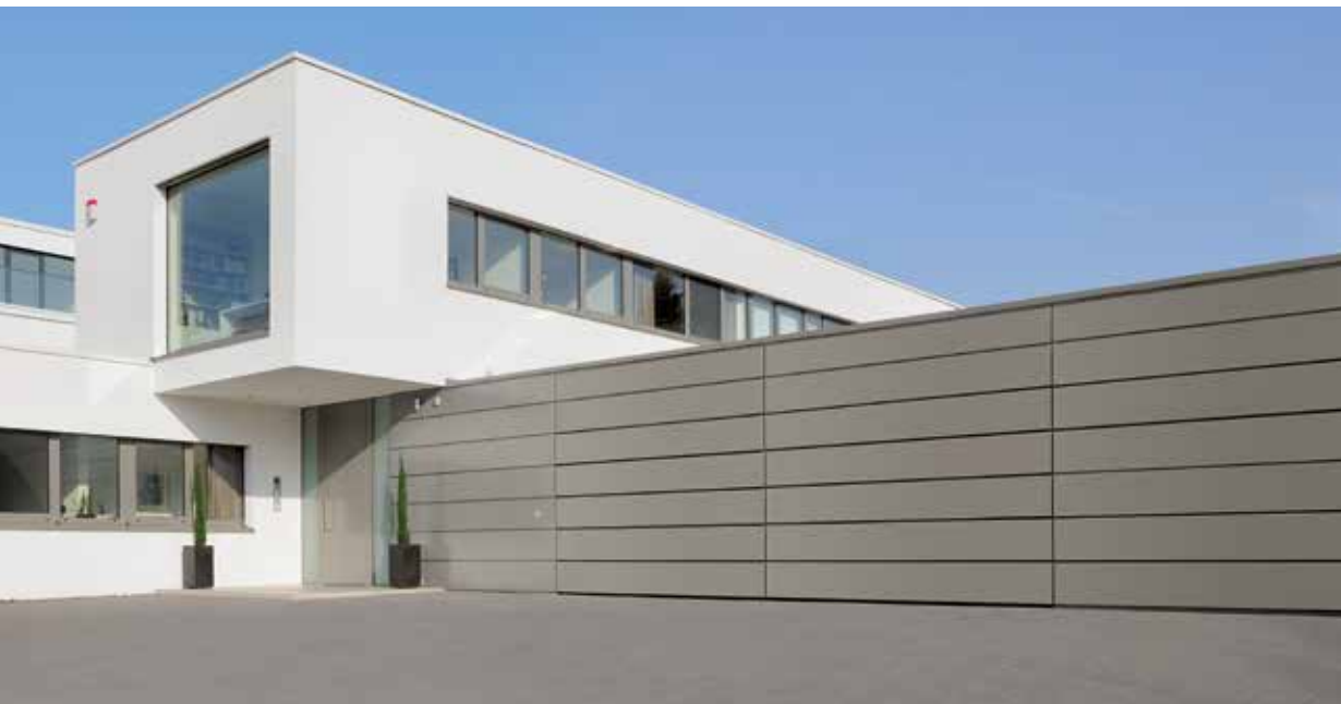
Bekleding door de klant met aluminium sandwichplaten
